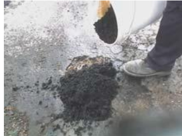
2. Vaciado de la mezcla y acomodo.
