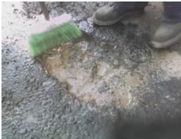
1. Barrido de la zona para eliminar material suelto y exceso de agua.
