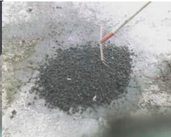
2. Vaciado de la mezcla y acomodo.
